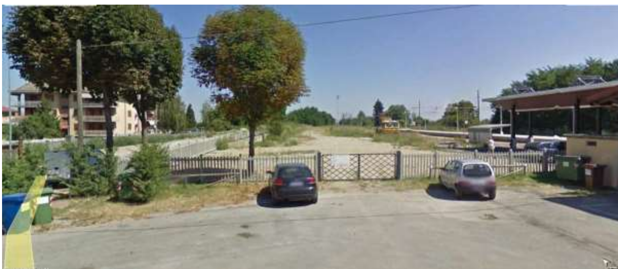
Area sottopasso ferroviario
